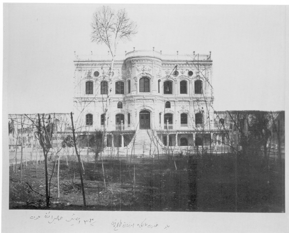
تصویر ۲- زیر نویس عکس به خط ناصرالدین شاه: "جلو عمارت خوابگاه [خوابگاه] اندرون طهران است سنه ۱۳۰۴ او دنیل جمادی الثانی حوت"، عکاس: حسینعلی. مأخذ: (سمسار، ۱۳۸۲، ۲۵۳)
