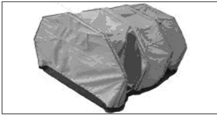
تصویر ۲۵- جاسازی لوله‌ها در داخل چادر.
