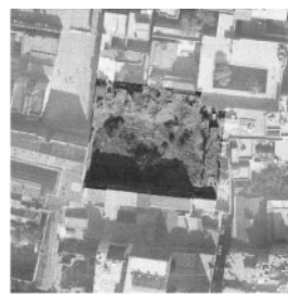
خانه تخریب شده در عکس ۱۳۸۱
