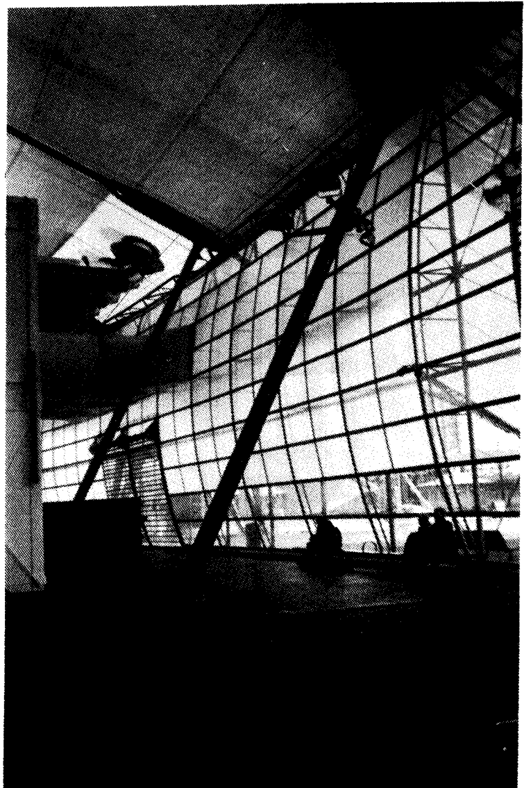
ورودی هوا و خروجی تهویه‌ها
